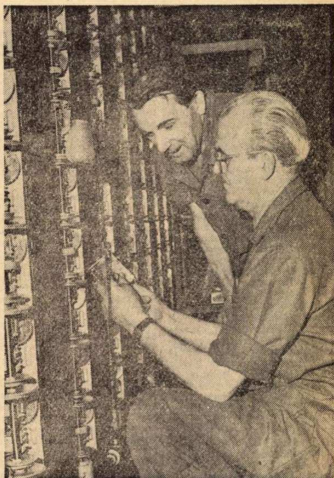
Ez a gép is jó... Georgevits Lajos (Lipót Üzem) és Kiss Mihály (BHG) a csoportválasztó gépek mechanikai hibáit hárítják el.
